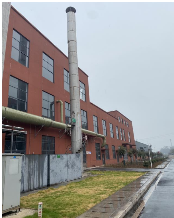
杀虫、杀菌剂液体车间生产线废气排放口
