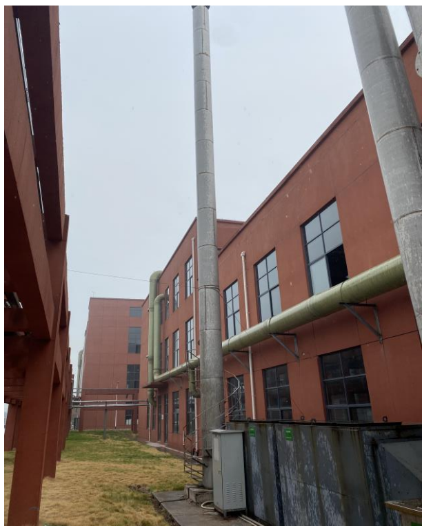
除草剂液体车间生产线废气排放口
