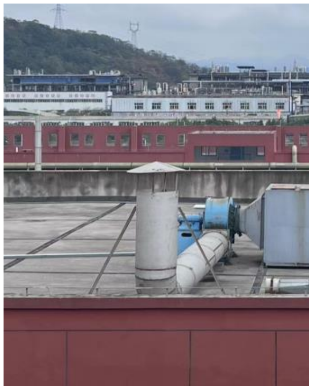
杀虫、杀菌剂液体车间换风废气排放口
