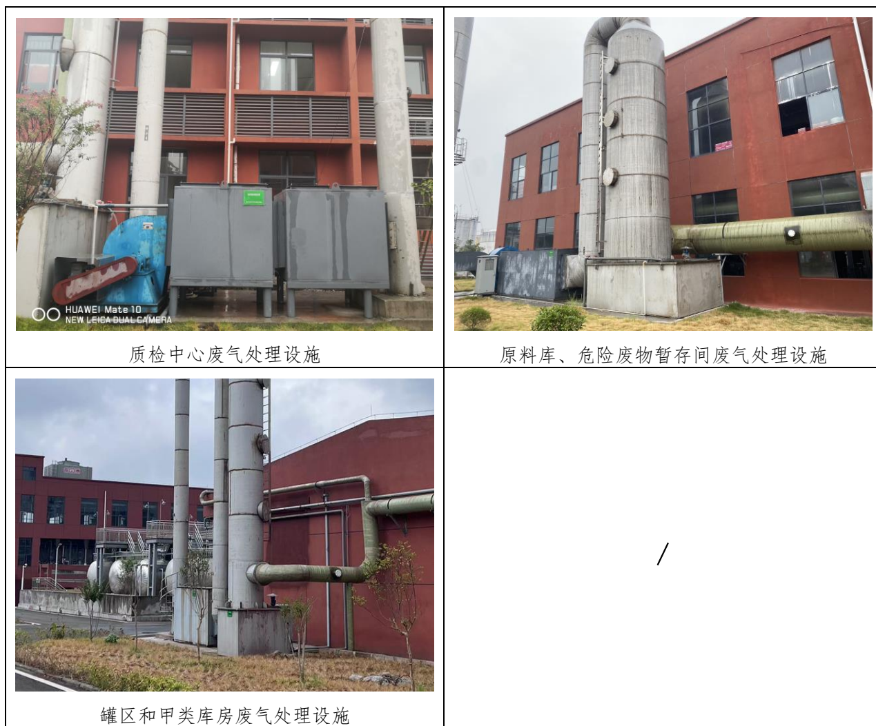
图 4.10 废气处理设施设置情况图
